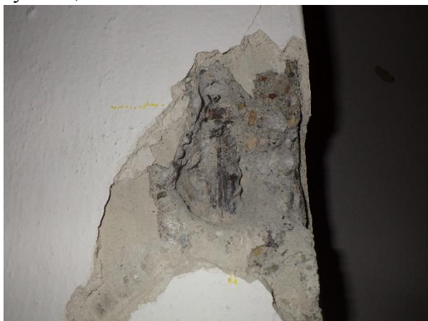
Foto č. 17-21 – sonda NS4 rámu RII -vně 2.NP - Pohled z boku, detaily výztuže,
