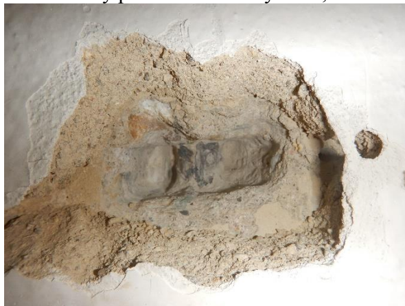
Foto č. 53-56 – sonda NS12 rámu RIV.-uvnitř 1.NP-celkové pohledy, detaily výztuží;
