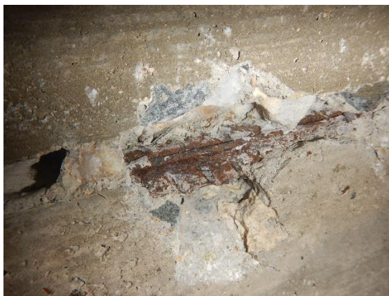
Foto č. 100-103 – sonda NV8 rámu RIV.- uvnitř 1.NP-details výztuží, pohled mimo sondu,
