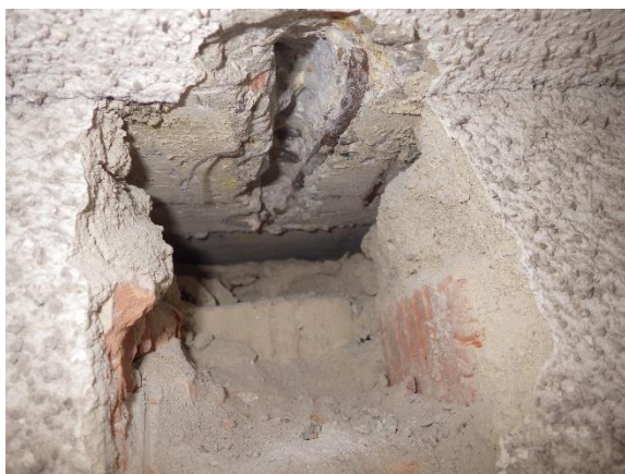
Foto č. 78-81 – sonda NV3 rámu RIV.-vně 2.NP-detaily výztuží,
