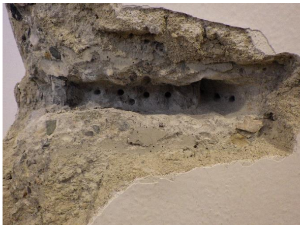
Foto č. 30-33 – sonda NS7 rámu RII.-uvnitř 1.NP-detaily výztuží
