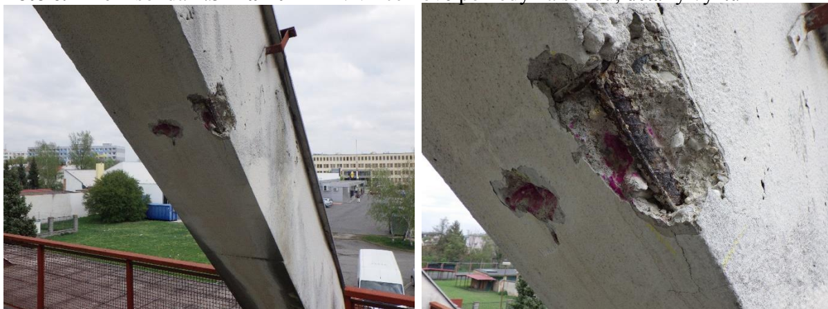
Foto č. 7-10 – sonda NS2 rámu RI -2.NP-celkové pohledy na sondu, detaily výztuží
