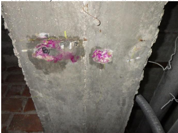
Foto č. 106-109 – sonda NV10 rámu RI.- uvnitř 1.NP-celkové pohledy a detail výztuže,
