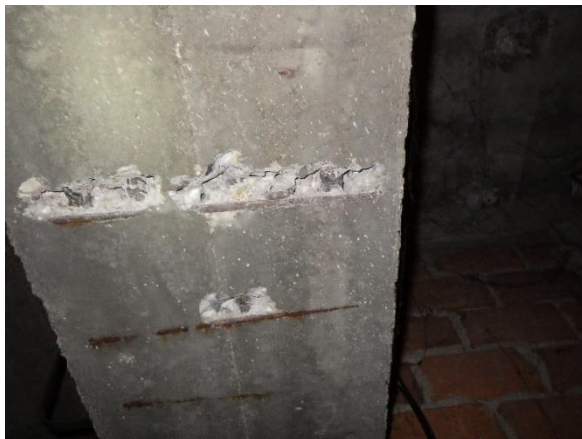
Foto č. 82-87 – sonda NV4 rámu RI.-uvnitř 1.NP-celkové pohledy, detail sondy, pohled mimo sondu
