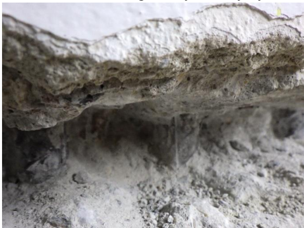
Foto č. 41-44 – sonda NS9 rámu RI.-uvnitř 2.NP-celkový pohled, detaily výztuží;
