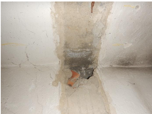
Foto č. 104-103 – sonda NV11 rámu RI-uvnitř 1.NP-details výztuží, pohled mimo sondu,
