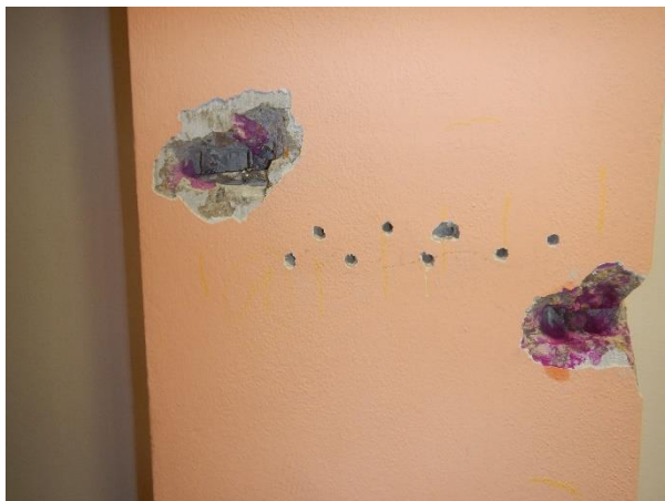
Foto č. 53-56 – sonda NS12 rámu RIV.-uvnitř 1.NP-celkové pohledy, detaily výztuží;
