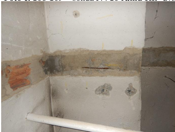
Foto č. 106-109 – sonda NV10 rámu RI.- uvnitř 1.NP-celkové pohledy a detail výztuže,
