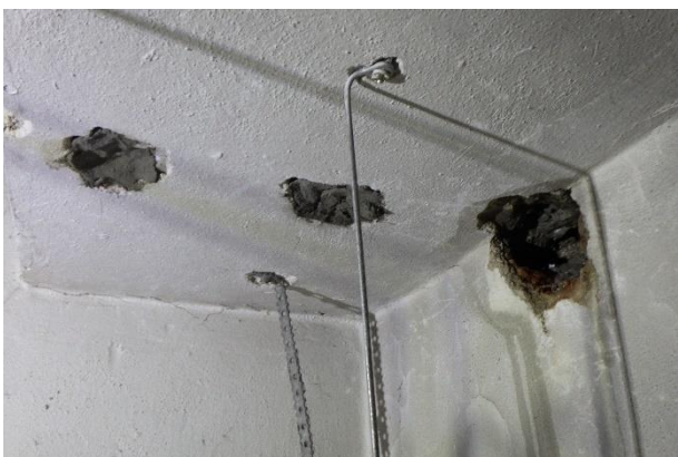
Foto č. 104-103 – sonda NV11 rámu RI-uvnitř 1.NP-details výztuží, pohled mimo sondu,
