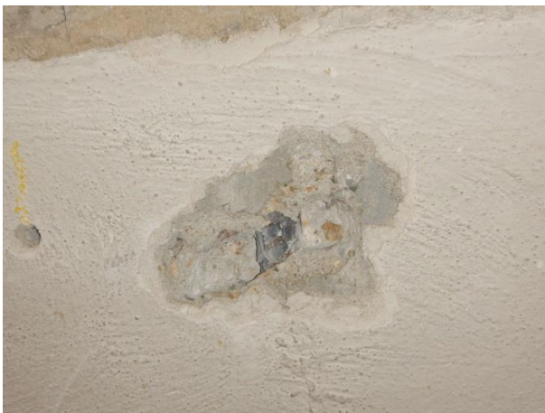
Foto č. 104-103 – sonda NV11 rámu RI-uvnitř 1.NP-details výztuží, pohled mimo sondu,
