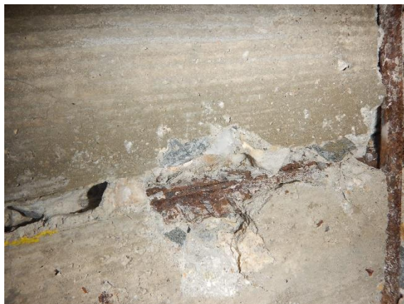
Foto č. 100-103 – sonda NV8 rámu RIV.- uvnitř 1.NP-details výztuží, pohled mimo sondu,
