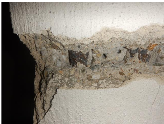
Foto č. 100-103 – sonda NV8 rámu RIV.- uvnitř 1.NP-details výztuží, pohled mimo sondu,
