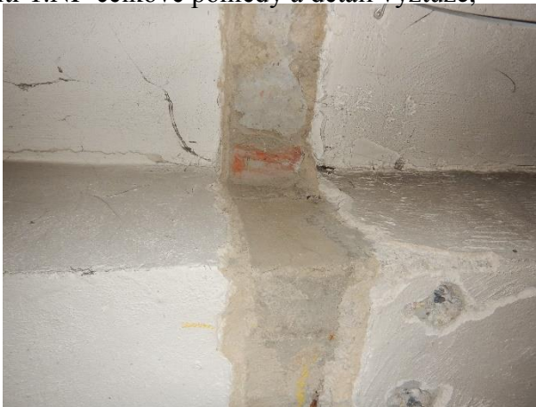
Foto č. 106-109 – sonda NV10 rámu RI.- uvnitř 1.NP-celkové pohledy a detail výztuže,
