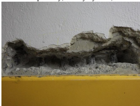
Foto č. 34-37 – sonda NS8 rámu RII.-uvnitř 1.NP-celkové pohledy, detaily výztuží;
