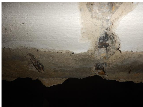
Foto č. 100-103 – sonda NV8 rámu RIV.- uvnitř 1.NP-details výztuží, pohled mimo sondu,
