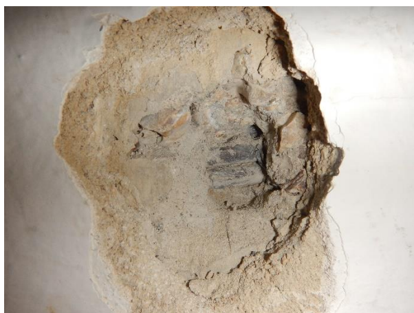
Foto č. 47-50 – sonda NS11 rámu RI.-uvnitř 1.NP-celkové pohledy, detaily výztuží,
