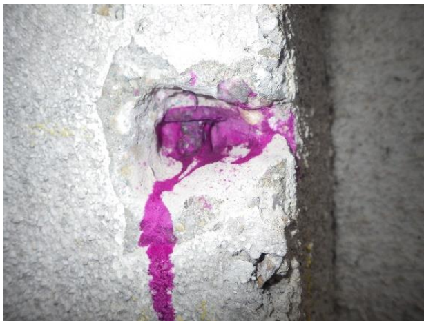
Foto č. 24-27 – sonda NS6 rámu RI-uvnitř 1.NP - celkový pohled, detaily výztuží,
