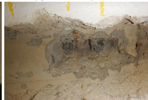
Foto č. 57;58 – sonda NS12 rámu RIV.-vně 1.NP-celkový pohled, detail výztuží;
