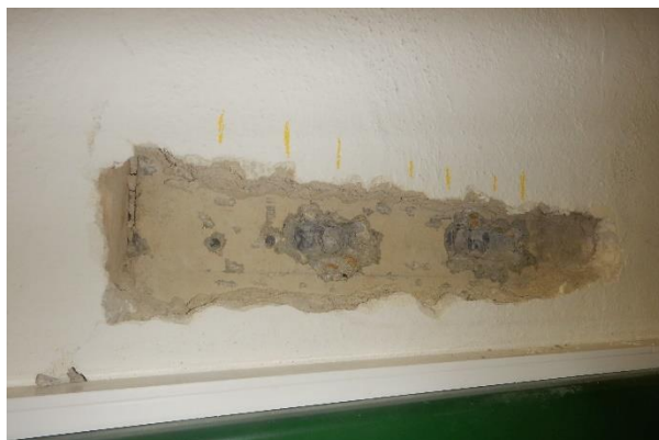
Foto č. 57;58 – sonda NS12 rámu RIV.-vně 1.NP-celkový pohled, detail výztuží;
