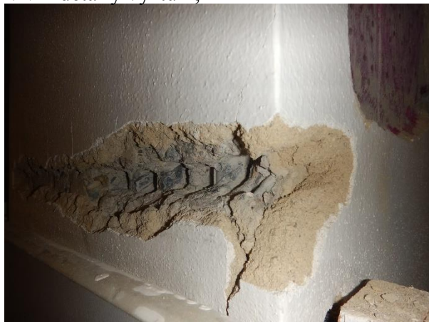
Foto č. 43-46 – sonda NS10 rámu RI.-uvnitř 1.NP- detaily výztuží;
