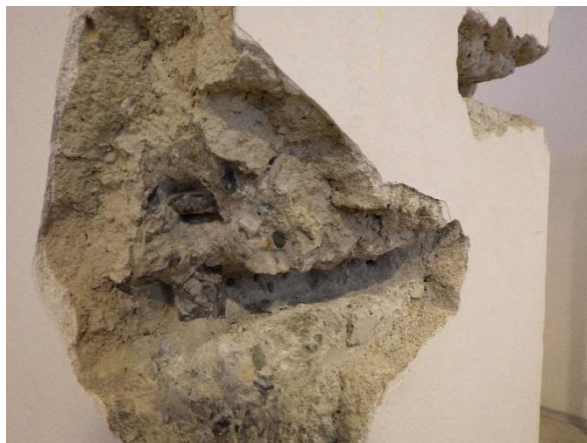
Foto č. 30-33 – sonda NS7 rámu RII.-uvnitř 1.NP-detaily výztuží
