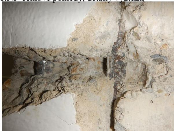
Foto č. 47-50 – sonda NS11 rámu RI.-uvnitř 1.NP-celkové pohledy, detaily výztuží,
