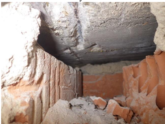
Foto č. 78-81 – sonda NV3 rámu RIV.-vně 2.NP-detaily výztuží,
