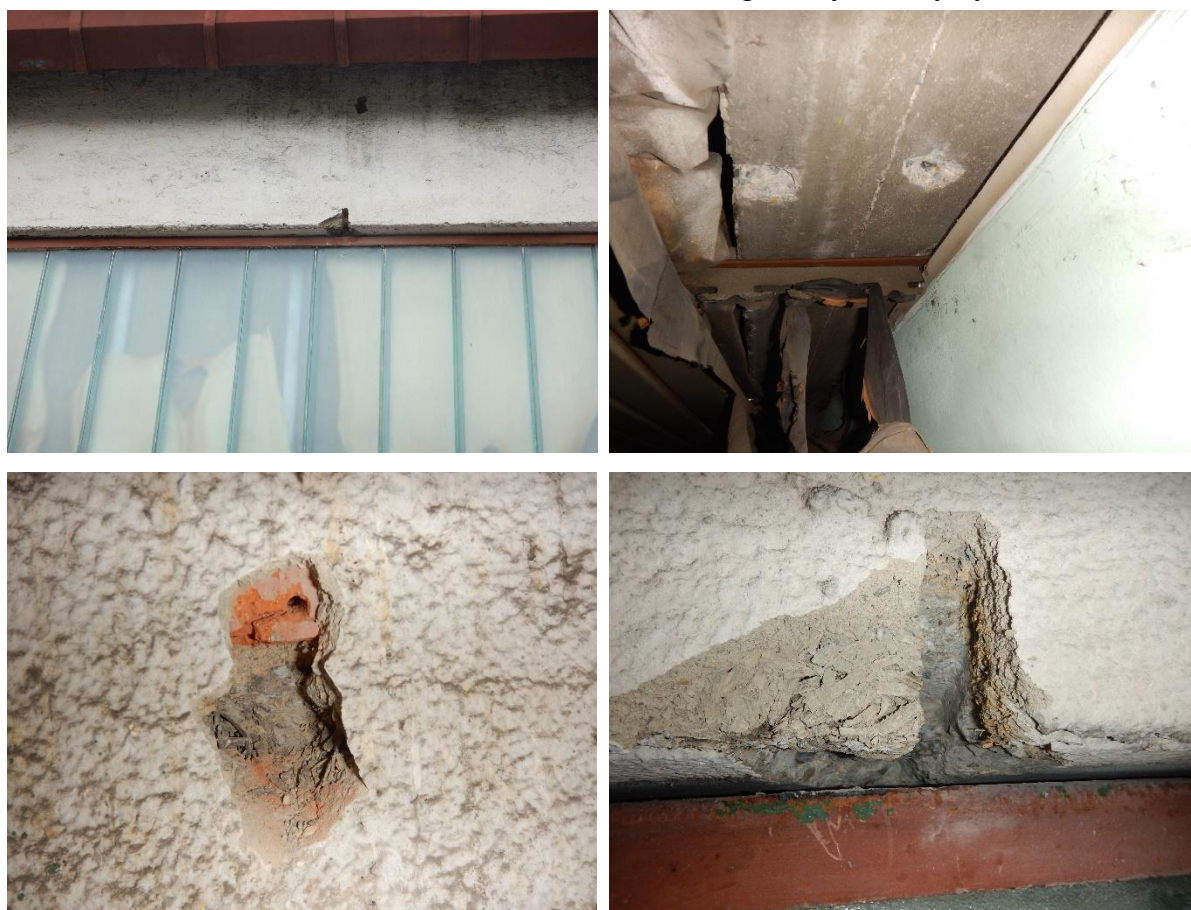
Foto č. 70-73 – sonda NV1 rámu RI.-vně 2.NP-celkové pohledy, detaily výztuží;
