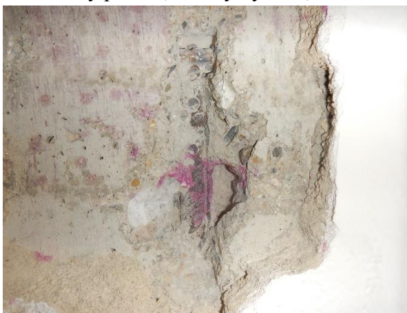
Foto č. 41-44 – sonda NS9 rámu RI.-uvnitř 2.NP-celkový pohled, detaily výztuží;
