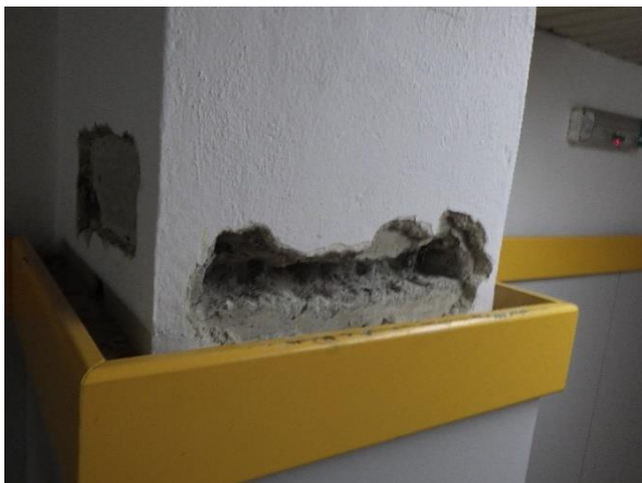
Foto č. 34-37 – sonda NS8 rámu RII.-uvnitř 1.NP-celkové pohledy, detaily výztuží;
