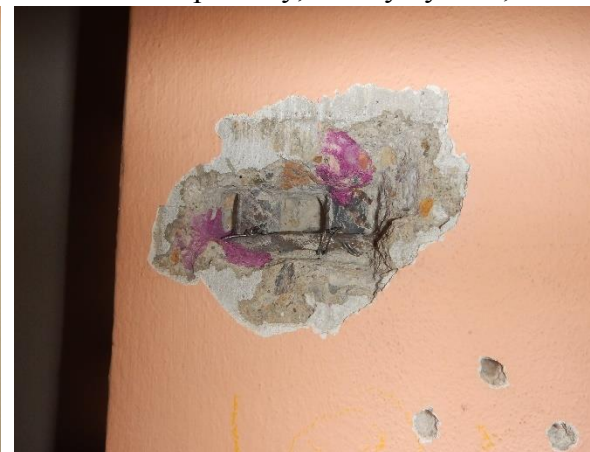
Foto č. 53-56 – sonda NS12 rámu RIV.-uvnitř 1.NP-celkové pohledy, detaily výztuží;
