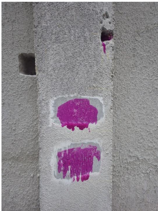
Foto č. 22;23 – sonda NS5 rámu RIV.-vně 2.NP-celkový pohled, detail výztuží,
