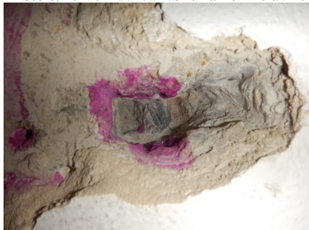
Foto č. 43-46 – sonda NS10 rámu RI.-uvnitř 1.NP- detaily výztuží;
