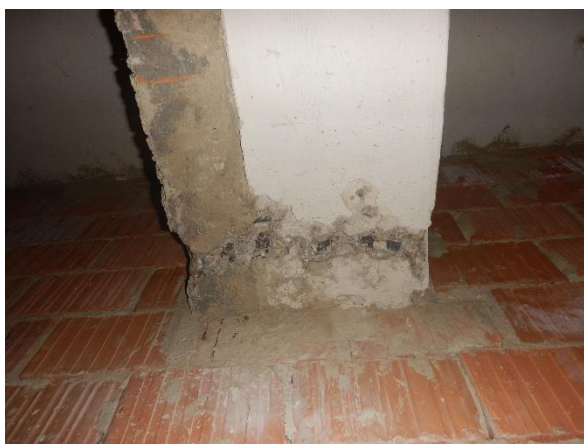
Foto č. 92;93 – sonda NV6 rámu RIV.- uvnitř 1.NP-detaily výztuží,
