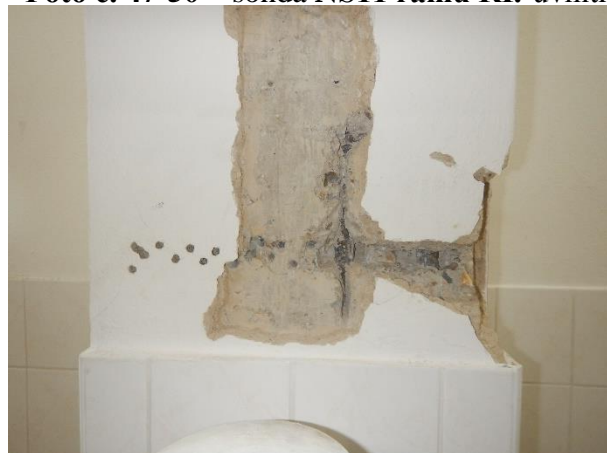
Foto č. 47-50 – sonda NS11 rámu RI.-uvnitř 1.NP-celkové pohledy, detaily výztuží,
