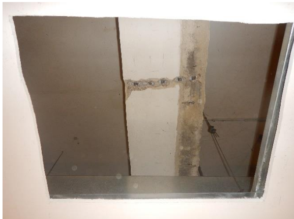
Foto č. 96-99 – sonda NV7 rámu RII.- uvnitř 1.NP-celkové pohledy a detail výztuží,
