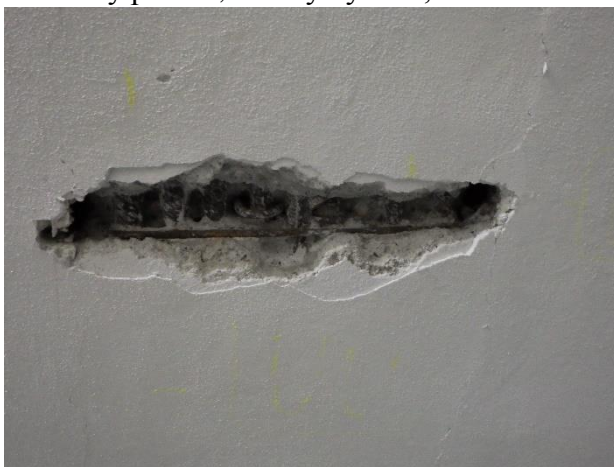
Foto č. 24-27 – sonda NS6 rámu RI-uvnitř 1.NP - celkový pohled, detaily výztuží,
