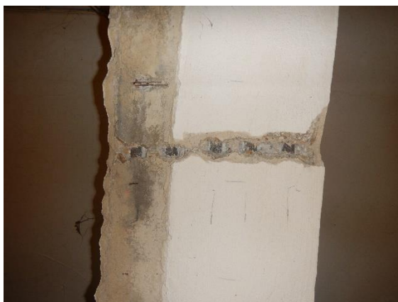
Foto č. 96-99 – sonda NV7 rámu RII.- uvnitř 1.NP-celkové pohledy a detail výztuží,
