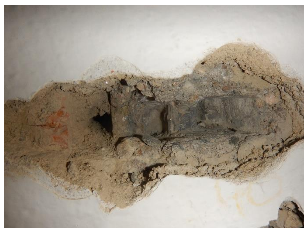
Foto č. 47-50 – sonda NS11 rámu RI.-uvnitř 1.NP-celkové pohledy, detaily výztuží,
