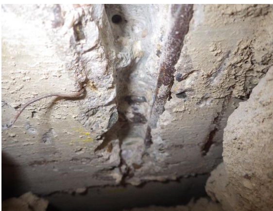
Foto č. 78-81 – sonda NV3 rámu RIV.-vně 2.NP-detaily výztuží,
