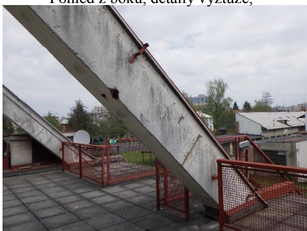
Foto č. 17-21 – sonda NS4 rámu RII -vně 2.NP - Pohled z boku, detaily výztuže,
