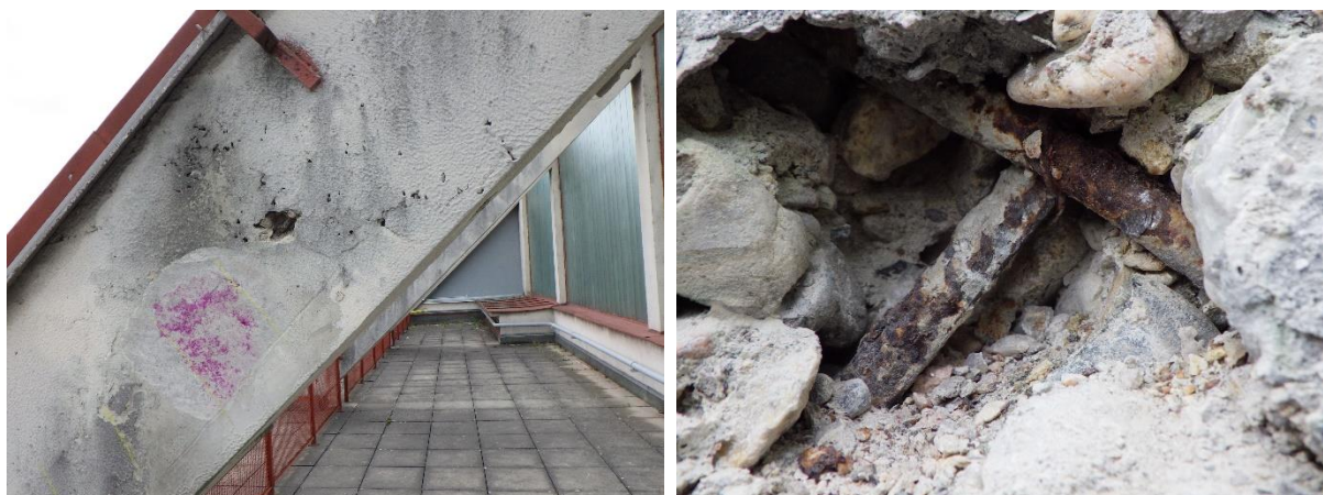
Foto č. 11– 14 – sonda NS3 rámu RII -vně 2.NP- celkové pohled na sondu, detail výztuží
